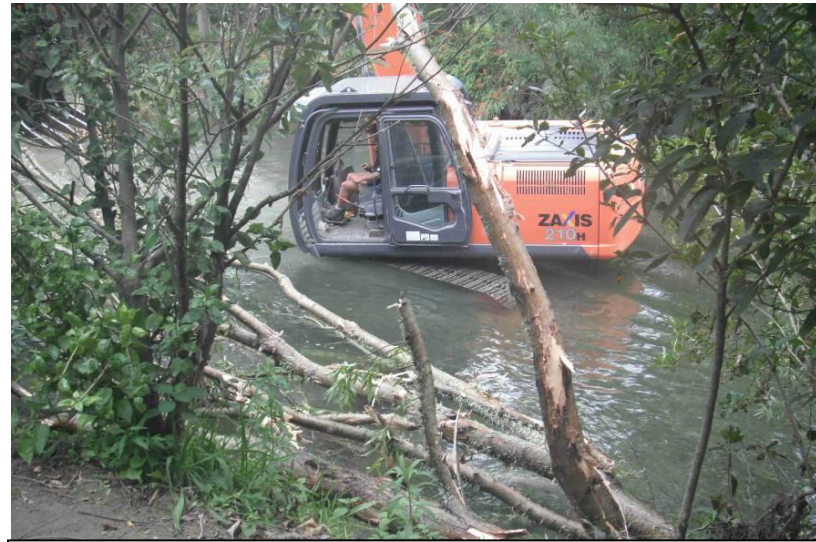
11 Tethering willows (Waikanae River)
