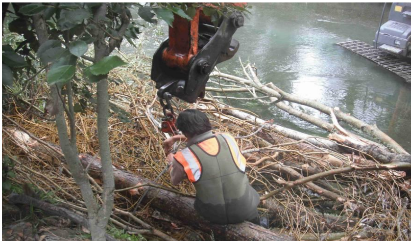
12 Tethering willows (Waikanae River)
