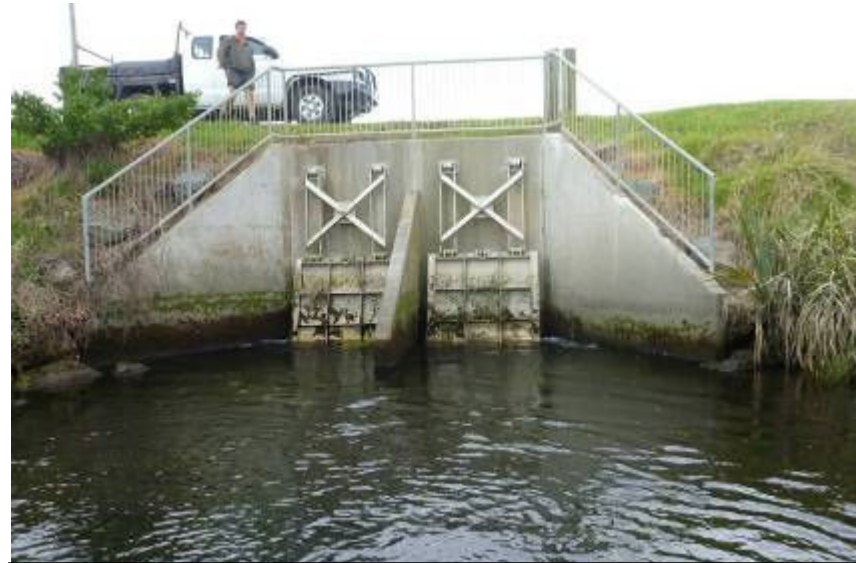
25 Rangiuru/Ngatoko Stream floodgates
